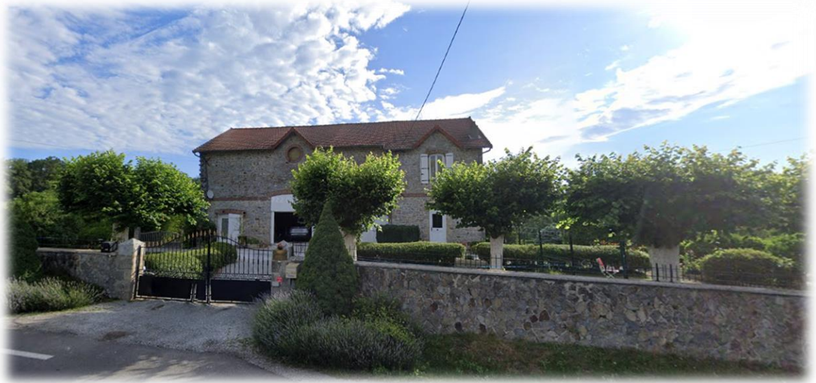
Photo 3 : vue de l'habitation à Villeneuve
